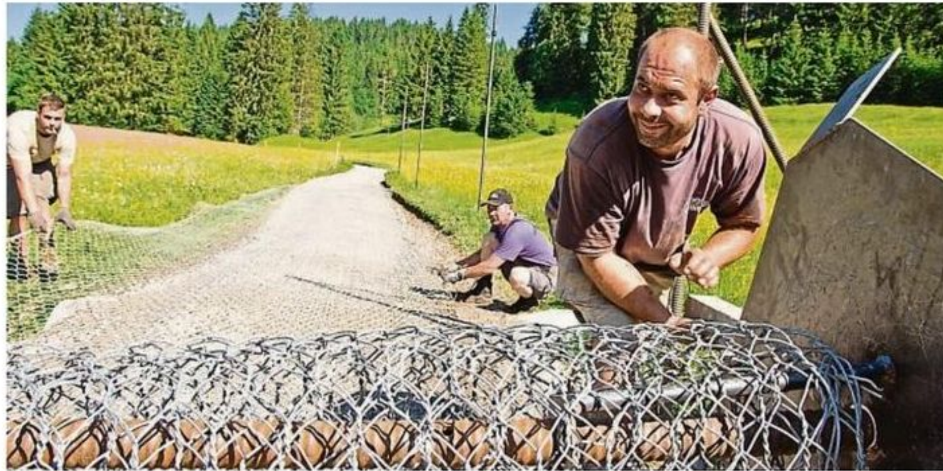
Wie angekündigt, verschwindet der Sicherheitszaun in der Nähe von Schloss Elmau gleich nach dem Gipfel. Die Mitarbeiter der Firma Geo Alpinbau aus Tirol bereitet den Abtransport vor.
