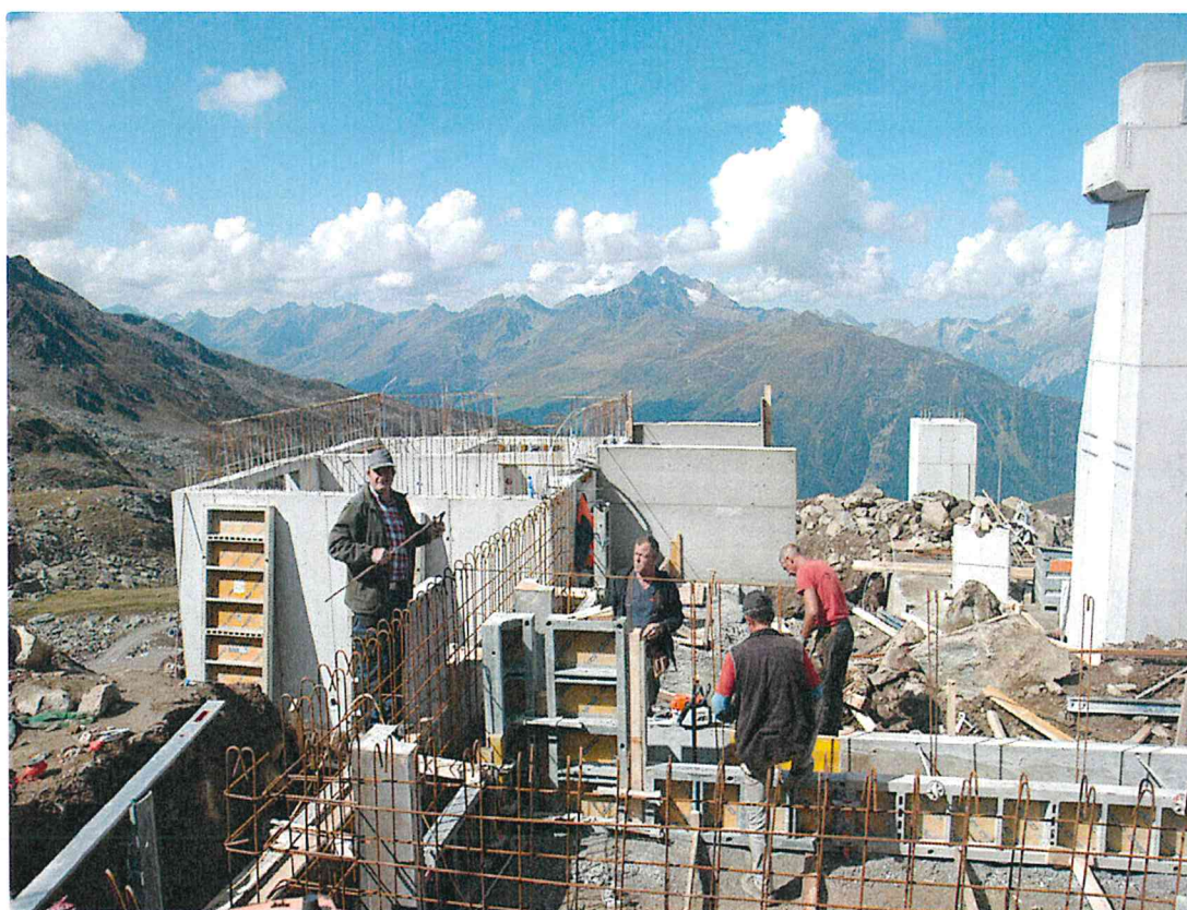
Die Bergstation der Versingbahn wächst jede Woche um einige Mauern.
