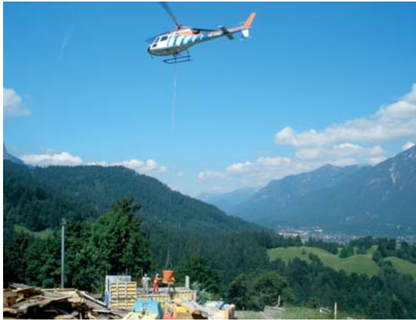
Der Materialtransport zur Baustelle war nur mit dem Helikopter möglich.
