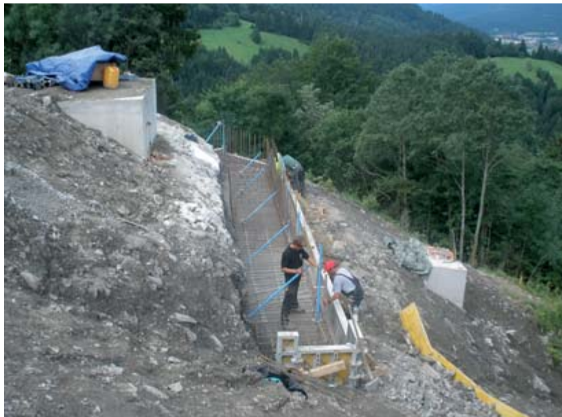
Der Großteil der Arbeiten musste in extrem steilem Gelände ausgeführt werden.
