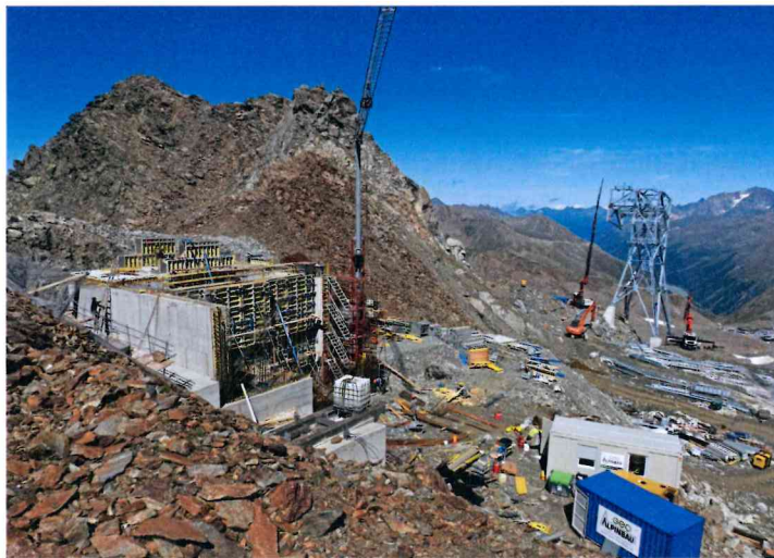
Die Bergstation entsteht.
